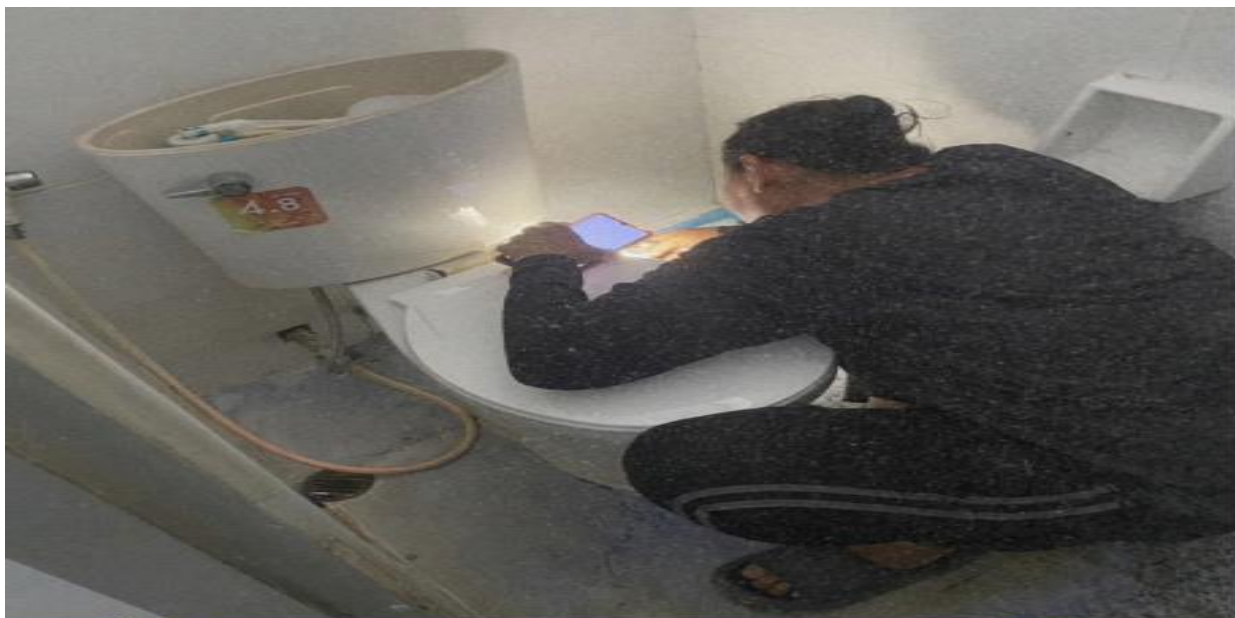
เปลี่ยนโถสุขภัณฑ์ใหม่ห้องน้ำหญิง
